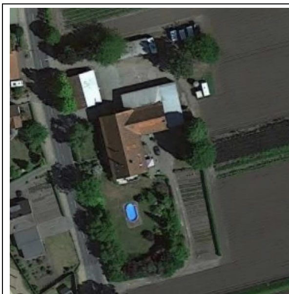
Hofstelle Kellerstraße 68 mit erkennbaren befestigten / bebauten Flächenanteilen
