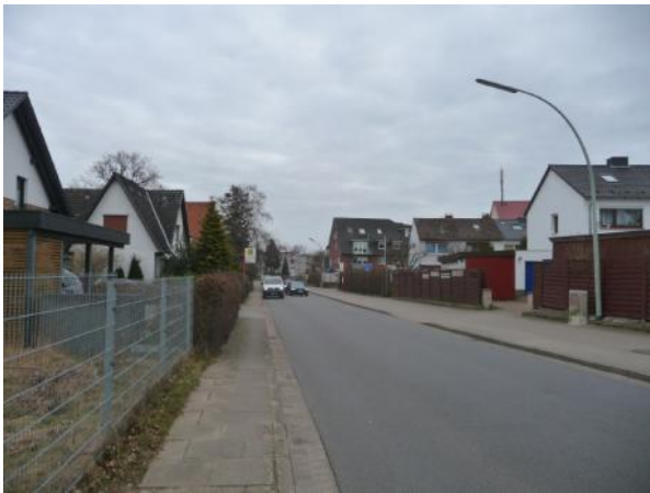
Abb. 2 Blick von der geplanten Plangebietsaus- und -zufahrt auf den „Ellerbeker Weg“ nach links
